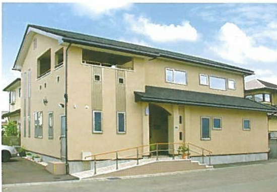
広い2階テラスは雨の心配がなく洗濯物が干せ、フリースペースとしても活躍します
